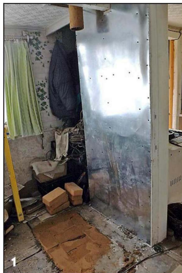
Первым делом нужно было защитить от перегрева стену рядом с печкой.
