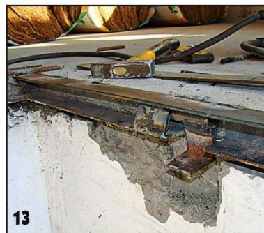
13 Для скрытых петель крышки люка использовал две купленные воротные петли.
