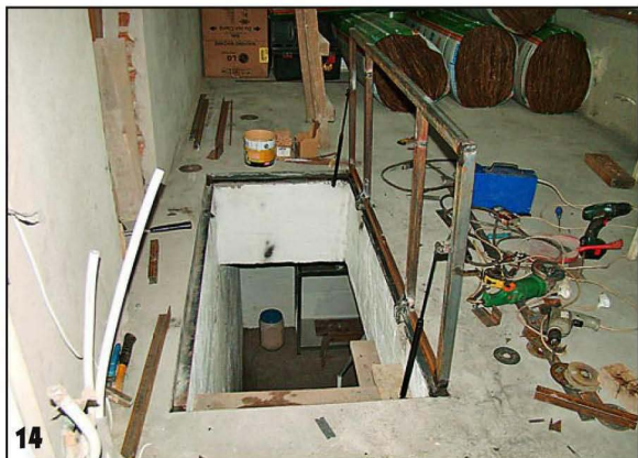
14 Основу для крышки люка сварил из трубы квадратного сечения 40x40 мм.
