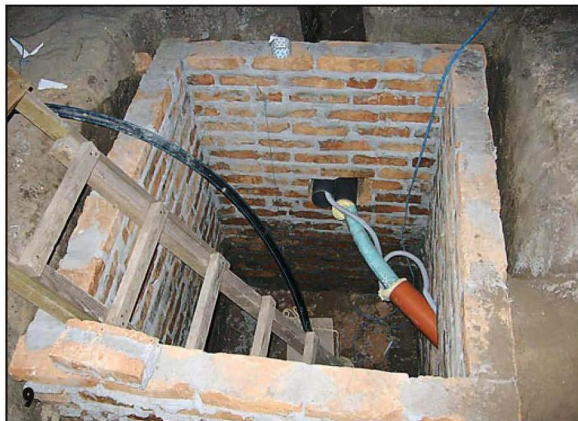
9 Смотровой колодец выложен из красного керамического кирпича.
