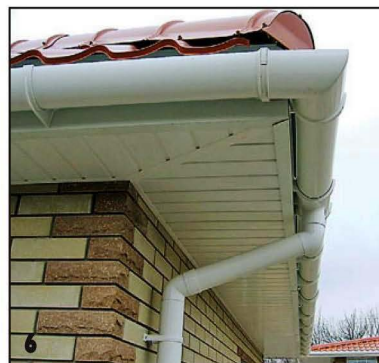
Вдоль свесов крыши установили сливы, а по углам постройки — водосточные трубы.
