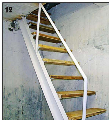
12 Ступени лестницы, ведущей в погреб, закреплены с одной стороны на швеллере, а со второй — на бетонной стене.
