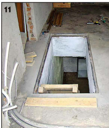
11 Бетонное перекрытие погреба получилось тёплым и прочным.
