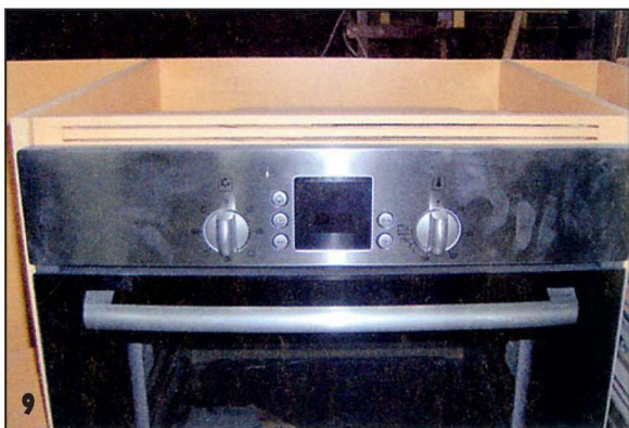
Верхняя перемычка тумбы для духового шкафа — из бука. В ней дисковой пилой по всей длине сделаны две сквозные прорези для обеспечения вентиляции внутреннего пространства тумбы при работающей духовке.
