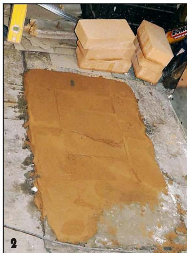
Кирпичную печь кладут на подготовленный фундамент.
