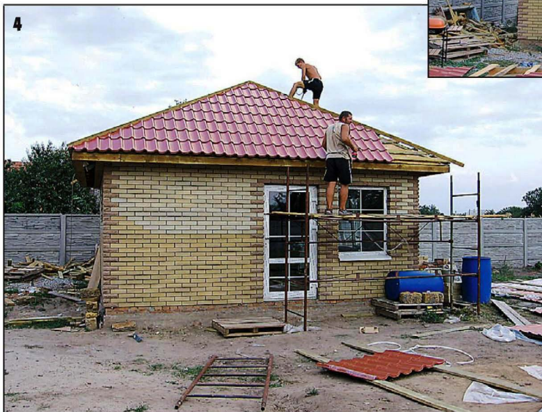
Вдоль свесов крыши установили сливы, а по углам постройки — водосточные трубы.
