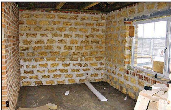
Стены бани выложены из ракушечника, перегородки — из красного кирпича.
