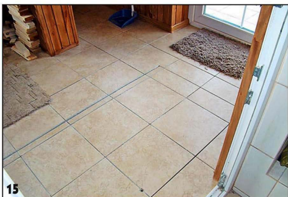
15 Люк сверху покрыл напольной плиткой.
